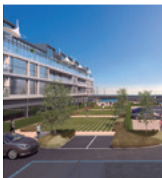
Přístavní vesnička Greystones. 205 bytů a 153 domů. Irsko. Aquarea
