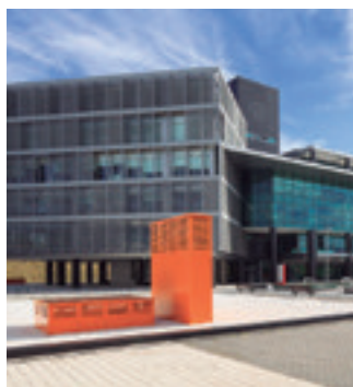
Andalucia Technology Park. Kanceláře s vysokou energetickou účinností. Španělsko. ECOi
